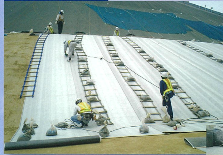
法面部接合状況
